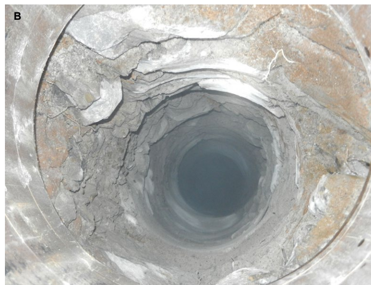
Figura 4.3 A) Una fase della terebrazione con i fanghi di perforazione. B) Vista dall'alto della porzione di pozzo incamiciata e di un tratto della perforazione.
