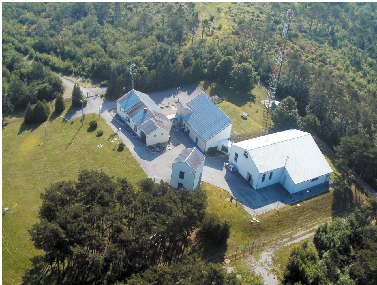
Figura 9.2 Impianto di depurazione di Sela na Krasu.
