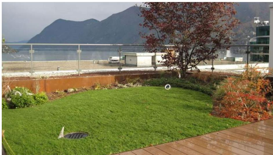
*Figura 3.6 – Aspetto di una copertura verde intensiva piana (fonte [www.daku.it](http://www.daku.it)).*
