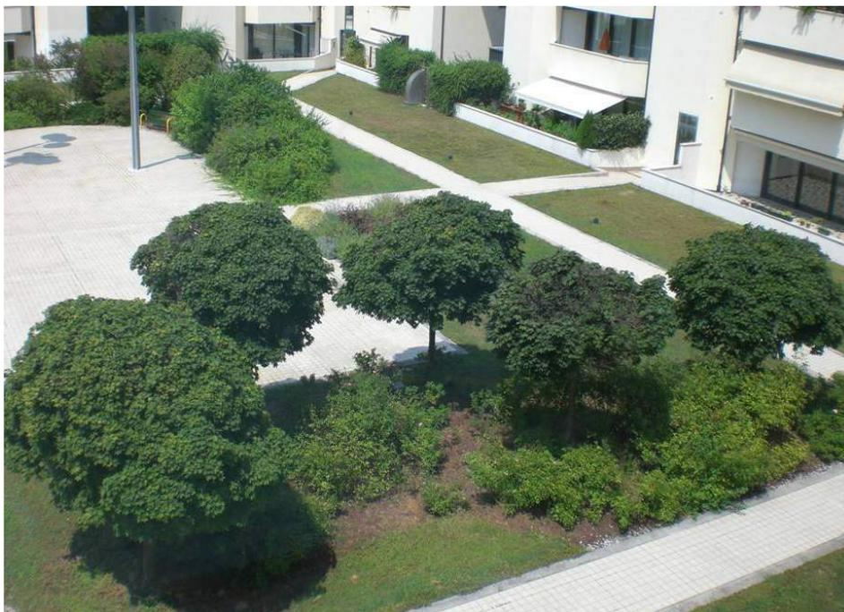
Figura 3.15 – Aspetto di una copertura verde intensiva pesante (fonte [www.daku.it](http://www.daku.it)).
