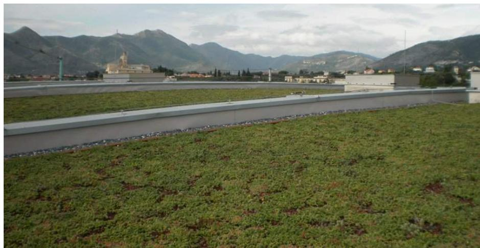
*Figura 3.2 – Aspetto dello strato di vegetazione di una copertura verde estensiva (fonte [www.daku.it](http://www.daku.it)).*
