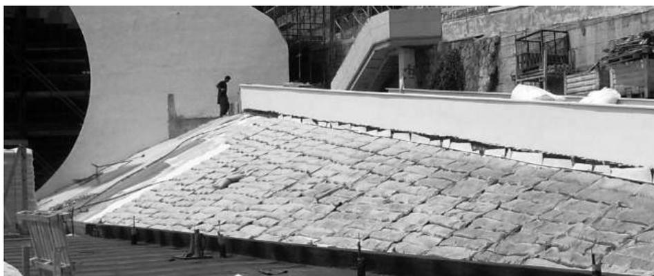
Figura 3.20 – Materassini di Igroperlite® in fase di realizzazione delle sistemazioni esterne dell'auditorium "Oscar Niemeyer" a Ravello (SA) (fonte [www.perlite.it](http://www.perlite.it)).
