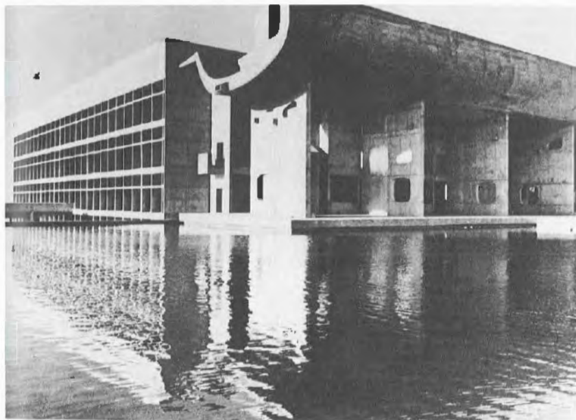
44. PALAZZO DELL'ASSEMBLEA, CHANDIGARH. LE CORBUSIER, 1946-1947. FACCIATA PRINCIPALE
