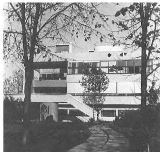
35. VILLA STEIN, FACCIATA POSTERIORE
