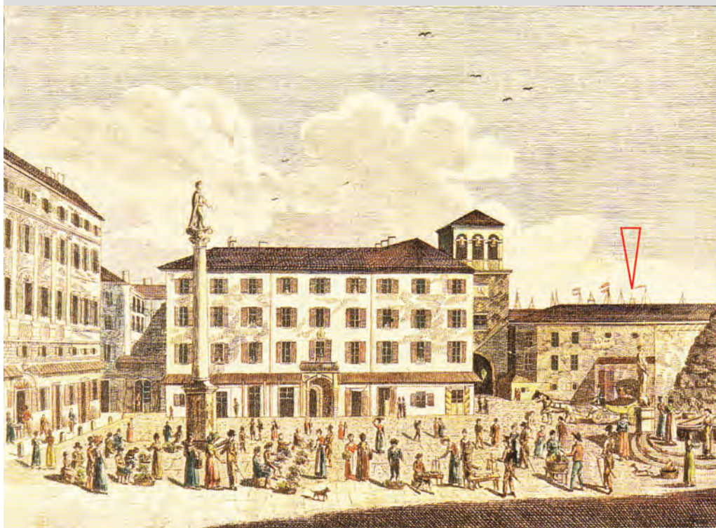
Der große Platz in Triest , incisione in rame a colori della piazza dopo la demolizione nel 1822 del Teatro S. Pietro 19 .
