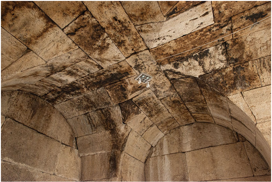
Fig. 3 Grotta dei Masacci. Groin vault in the inner chamber
