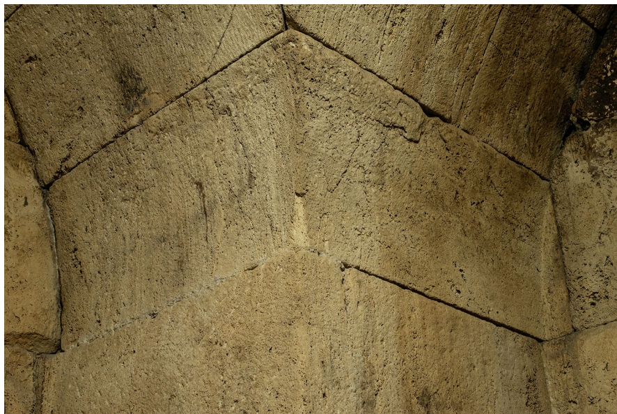
Fig. 14 Vault at the Grotta dei Masacci. Detail of the springings
