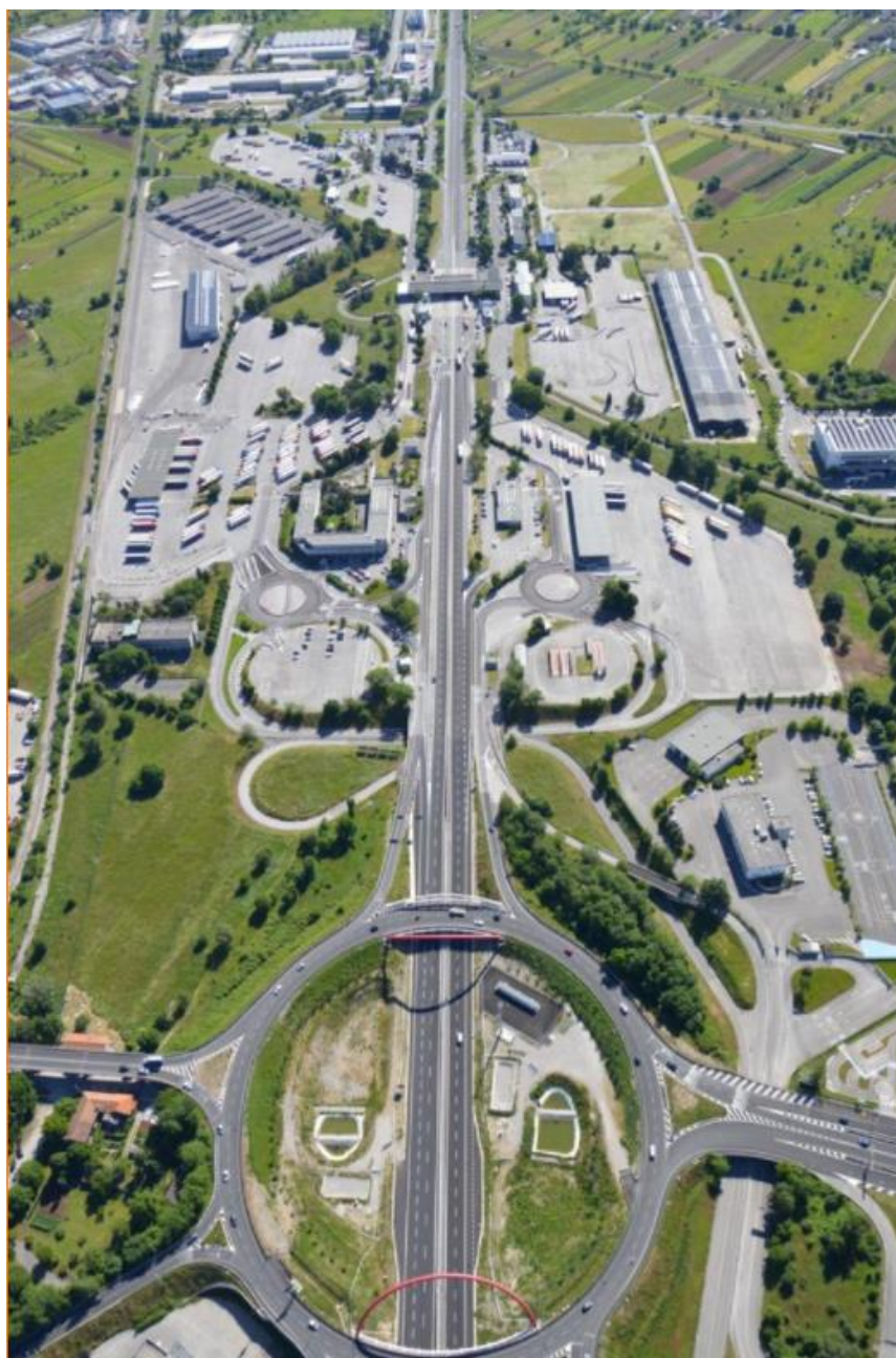
Figura 16 - Il complesso dell'interporto di Gorizia situato nell'area di Sant'Andrea. Si estende su un'area di 600.000 mq. Fonte dell'immagine: https://www.sdag.it/it/lazienda/
