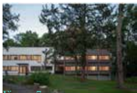
Figura 7 Foto attuale del Pavillon Pussin de Soisy dell'Hopital l'Eau Vive, ristrutturato nel 2021 dagli Architetti Toli+Gilliland. [https://tolilagilliland.com/Hopital-l-Eau-Vive-Soisy-sur-Seine]
