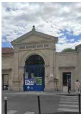
Portale dell'ingresso principale. [foto dell'autrice Di Prisco, M.]
