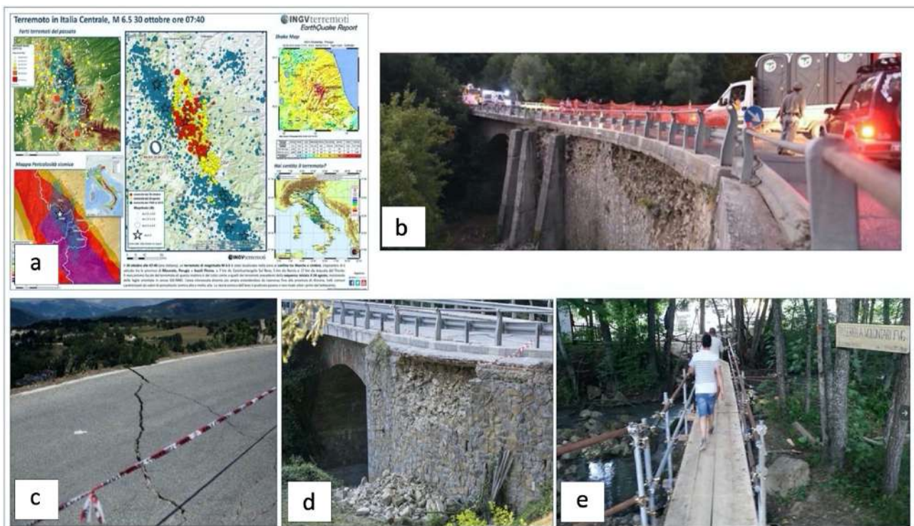
Fig. 1.21) Descrizione del sisma di M_w=6 avvenuto in Centro-Italia nel 2016. a) Sequenza Sismica dell'evento di M_w=6 (fonte: INGV); b) Esempio di chiusura del ponte a Tre occhi sulla strada regionale 260 un'importante via di accesso verso il comune di Amatrice "Immagine digitale" (fonte: Cronache Cittadine (2016): "Terremoto Accumoli. Domani 3 Settembre apertura al traffico del bypass del ponte "A tre occhi" sulla "Picente" in Comune di Amatrice 2 Settembre 2016 Redazione Altri Centri, Amatrice, Astral, Cronaca, ponte "A Tre Occhi", riapertura ponte, SR 260 Picente, Terremoto Accumoli, Trasporti, viabilità" https://www.cronachecittadine.it/terremoto-accumoli-domani-3-settembre-apertura-al-traffico-del-bypass-del-ponte-a-tre-occhi-sulla-picente-in-comune-di-amatrice/ Data di consultazione 25 luglio 2022); c) Esempio di danneggiamento SS4 Salaria "Immagine digitale"(fonte: RAINews (AGOSTO 24 2016) "ITALIA La viabilità nelle zone terremotate Questa la situazione della viabilità, resa nota dalla Polizia, nelle zone dell'Italia centrale colpite dal terremoto" https://www.rainews.it/archivio-rainews/articoli/La-viabilita-nelle-zone-terremotate-af995e17-e44e-442e-82d6-5b800e15c309.html Data di consultazione 25 luglio 2022); d) Esempio di chiusura del ponte a Tre occhi sulla strada regionale 260, un'importante via di accesso verso il comune
