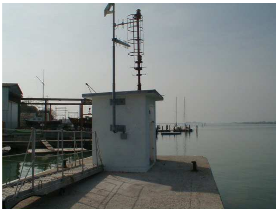
Figura 5.4: Stazione anemometrica di Grado (GO) (ISPRA).
