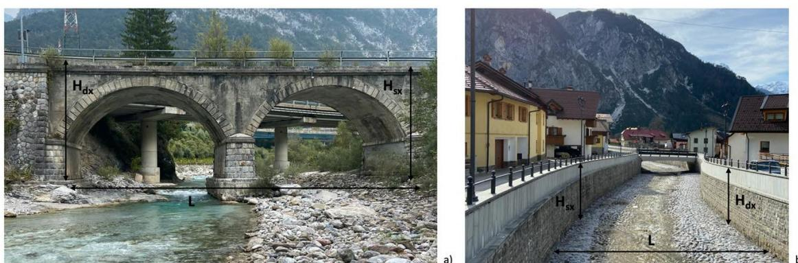
Figura 4.3: Alveo naturale della sezione di chiusura a Pontebba (a) e alveo artificiale della sezione di chiusura di Ugovizza (b).
