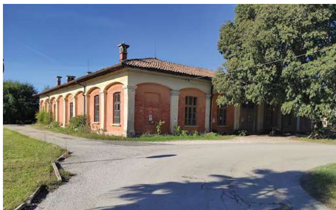
Fig. 6 • Foto del Parco Basaglia di Gorizia, degli edifici e degli spazi esterni che li circondano, con codice che fa riferimento alle planimetrie di studio precedentemente riportate. Dall'alto: neuropsichiatria infantile e uffici Azienda sanitaria (8), costruito al posto dell'ex padiglione dei tranquilli; coop. sociali "Il Grande Carro" e "Orizzonte", Ex bar (17); ex padiglione del lavoro (21). Foto dell'autrice, 2020.
