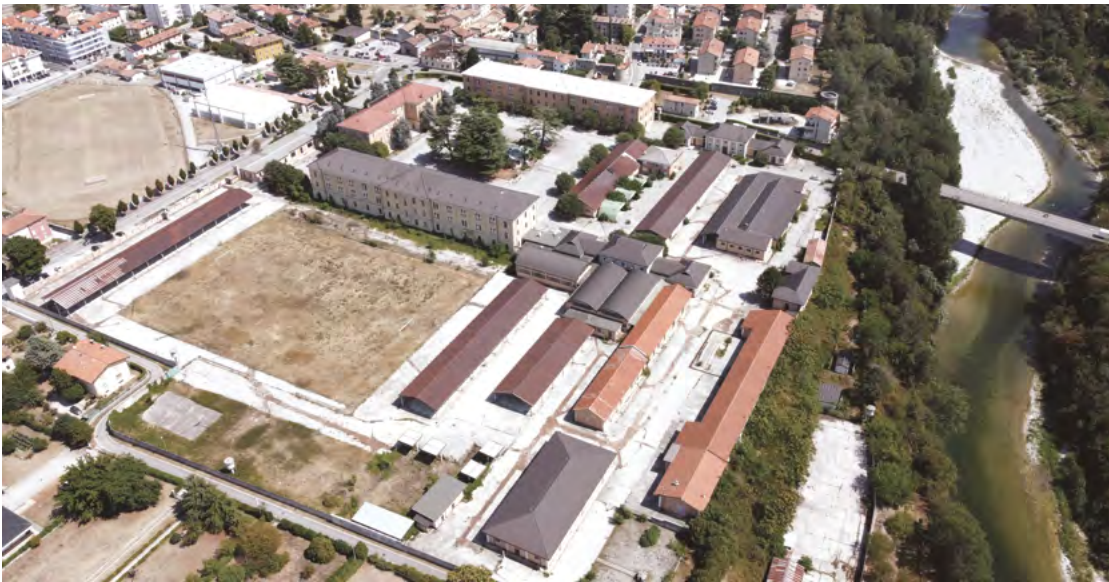
02. Veduta aerea della caserma Francescatto di Cividale | Aerial view of the Francescatto Barracks in Cividale. T. Bisiani, A. Venudo
