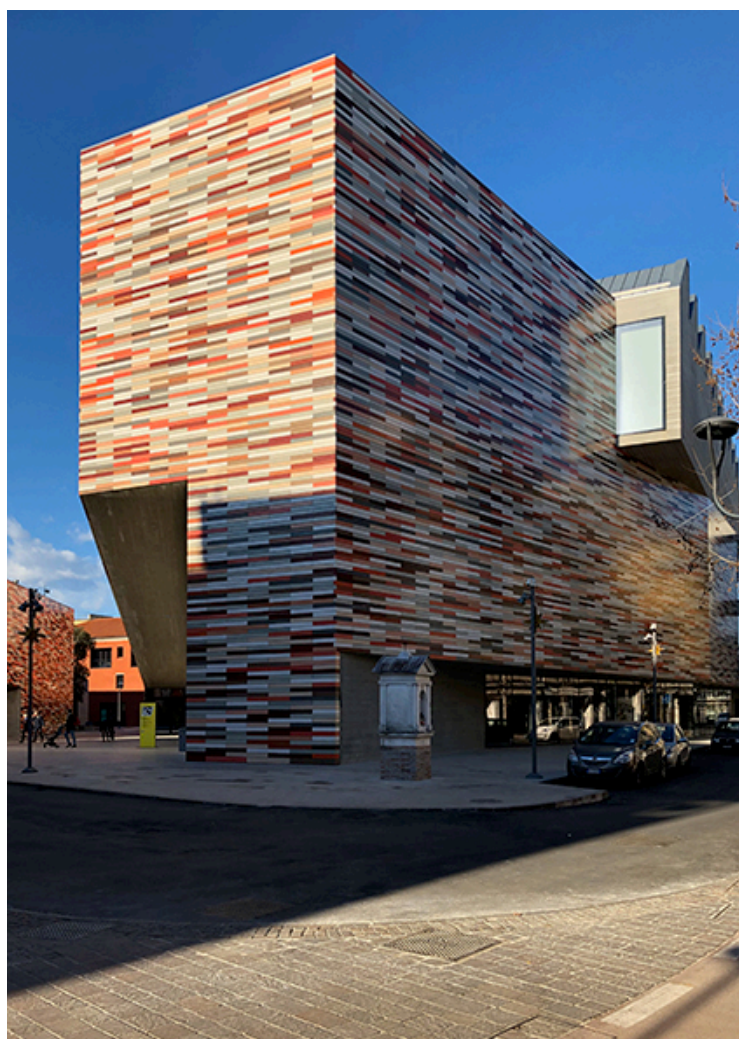
Fig. 2 – L'M9 di Sauerbruch & Hutton (foto dell'autore)
