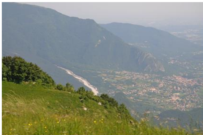
Figura 4. L'ampio cono di deiezione terrazzato del Torrente Vegliato inquadrato dal Monte San Simeone. Il cono costituisce una parte del sito urbanizzato di Gemona del Friuli (Foto: M. Stoppa).
