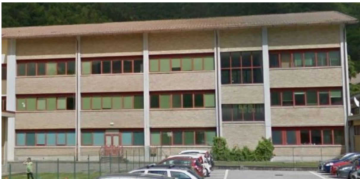
Fig. 77. Facciata sud-ovest dell'edificio
