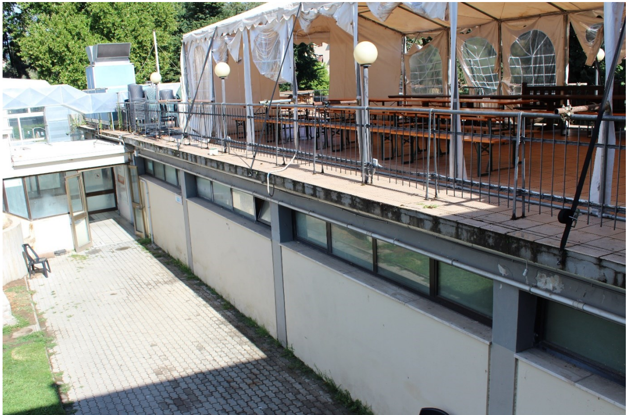
Fig. 60. Vista della terrazza esterna del ristorante
