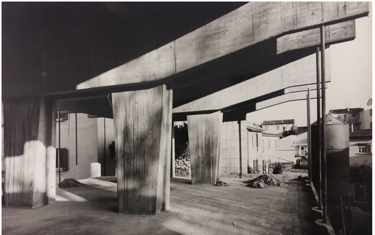
Fig. 19. G. G. Gori, D. Cardini, R. Raspollini, E. Brizzi, Sede dell'Automobile Club , cavalletti e travi a doppio sbalzo in costruzione, foto del cantiere, Firenze (Archivio Giuseppe Giorgio Gori, Biblioteca di Scienze Tecnologiche di Firenze)
