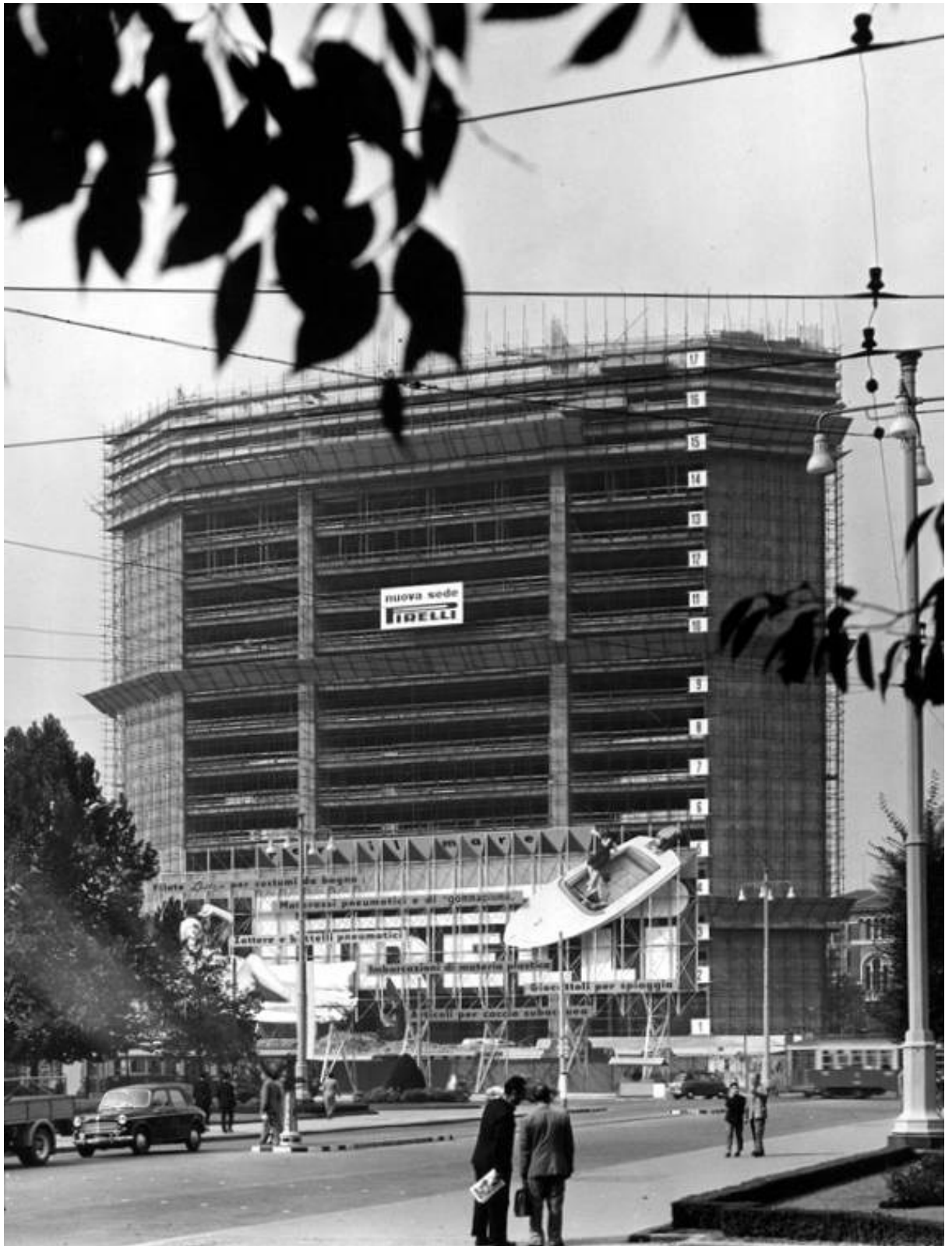
Fig. 5. P.L. Nervi, G. Ponti, G. Valtolina, Grattacielo Pirelli , cantiere in fase di realizzazione, foto d'epoca, Milano 1956-1960
