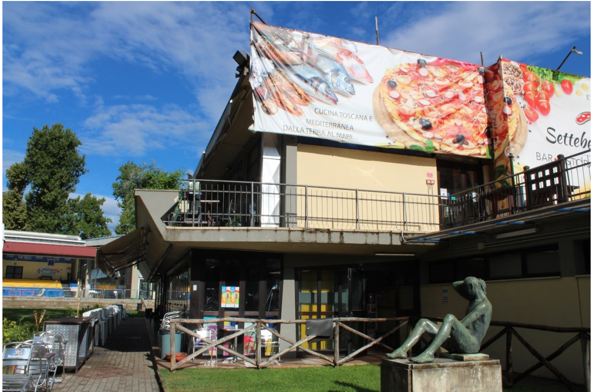
Fig. 58. Vista laterale dell'edificio
