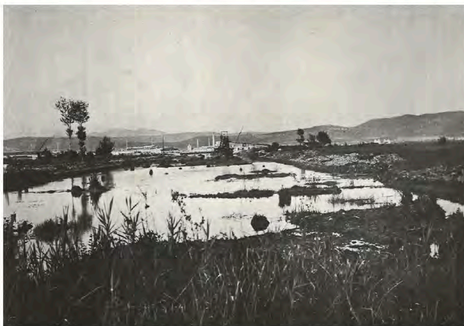
Figura 3 | Scavo del tratto navigabile del Canale Principale 1° di bonifica in località “Cavanna di Monfalcone”. Sullo sfondo i cantieri navali e le ciminiere della Società Solvay. Fonte: Archivio Consorzi Riuniti - Ronchi dei Legionari, 1927.
