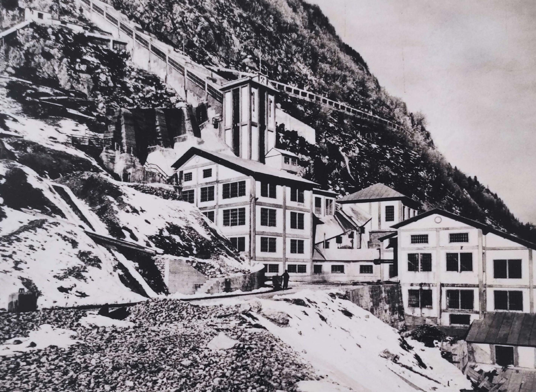
Cave del Predil, fine anni Cinquanta. Veduta impianti lato Sud, laveria Archivio ALEA scarl, Cividale del Friuli
