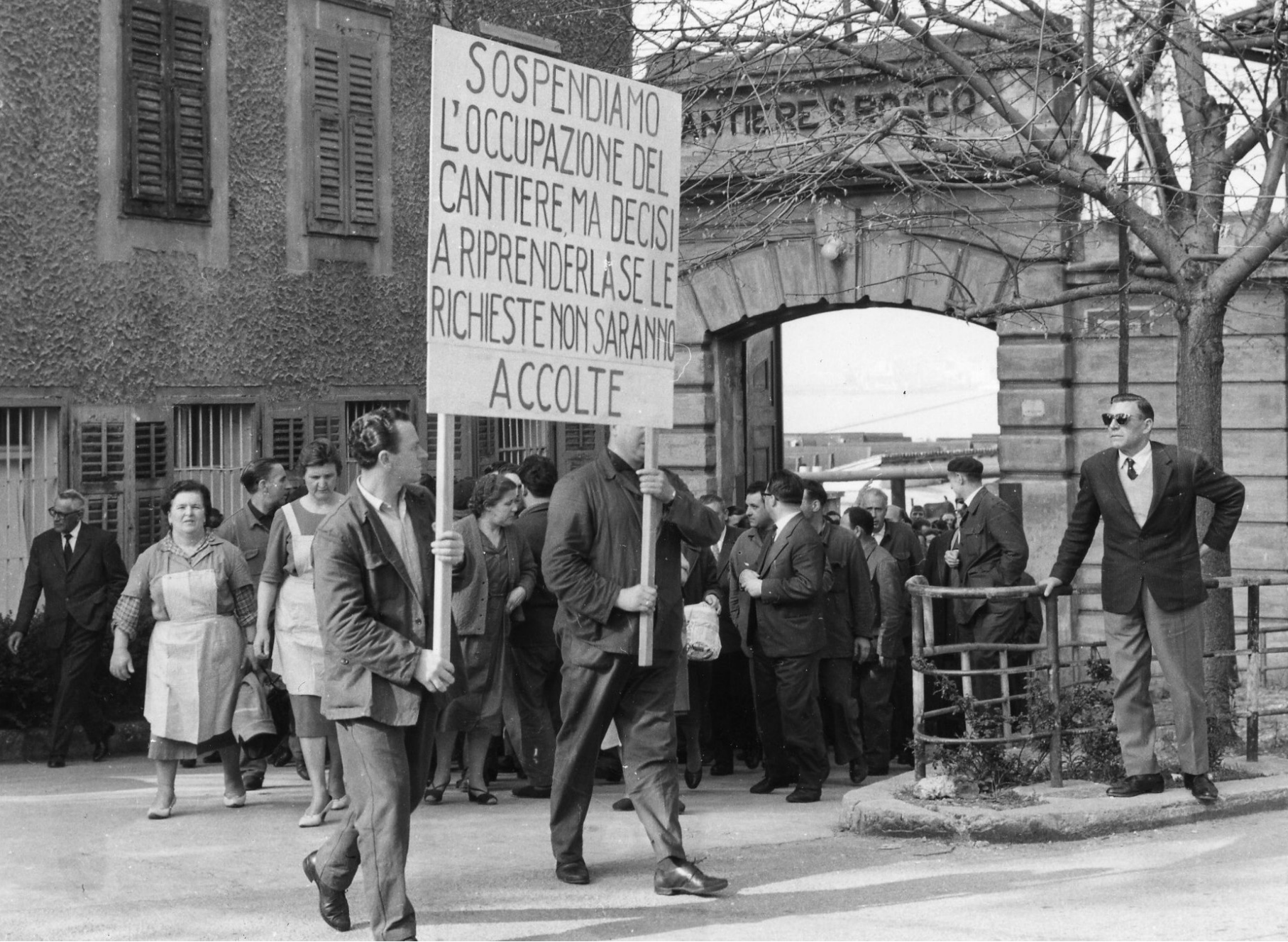
Muggia 1961. Sciopero Cantiere San Rocco
