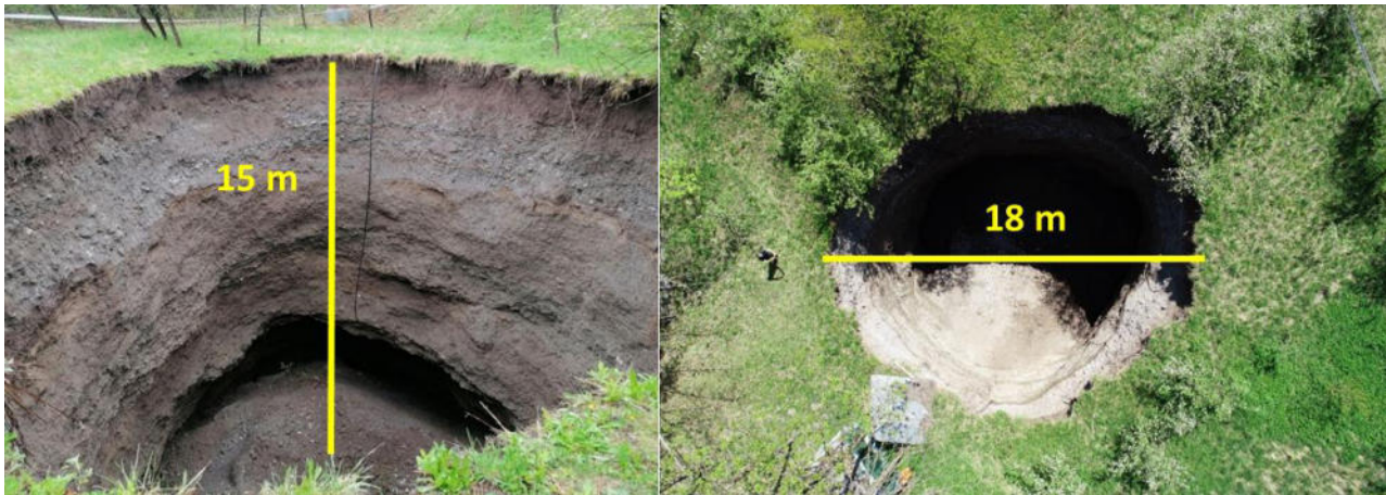
Figure 47 The collapse sinkhole of Esemone di Sopra
