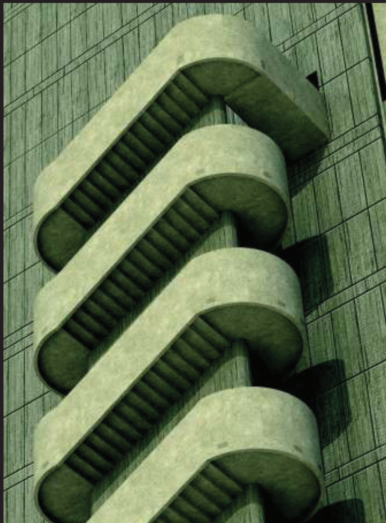
Particolare scala esterna (elab. Pietro Carriero)
