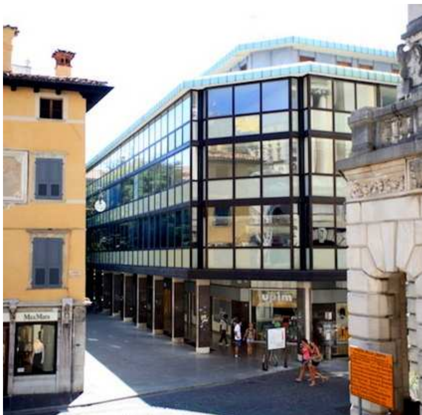
Udine, l'ex magazzino UPIM oggi.
