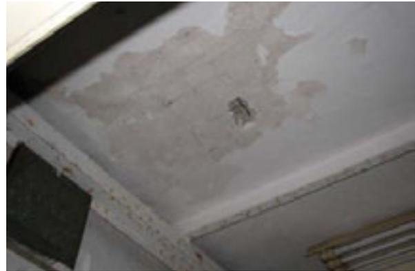
31. Dettaglio del solaio d'interpiano di villa Lasciac, con foro di sondaggio.
