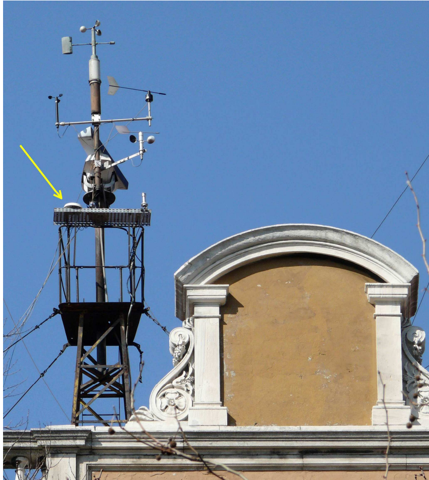
Fig. 2.- Posizione originale del piranometro sul traliccio del radar.
