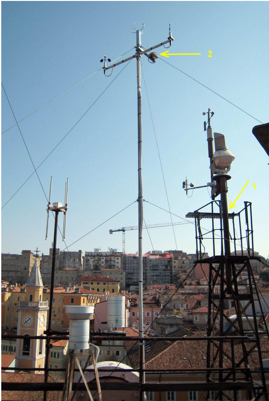
Fig. 1.- Posizione del piranometro Kipp&Zonen CM11 sul tetto dell'ISIS Nautico in piazza Hortis; (1) mensola sul traliccio del radar sino al 23/2/2012, (2) sul palo degli anemometri, rivolto a sud.
