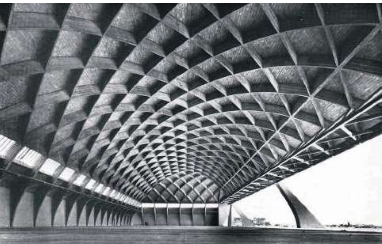
7 Pier Luigi Nervi, Hangar, Orvieto, 1935.
