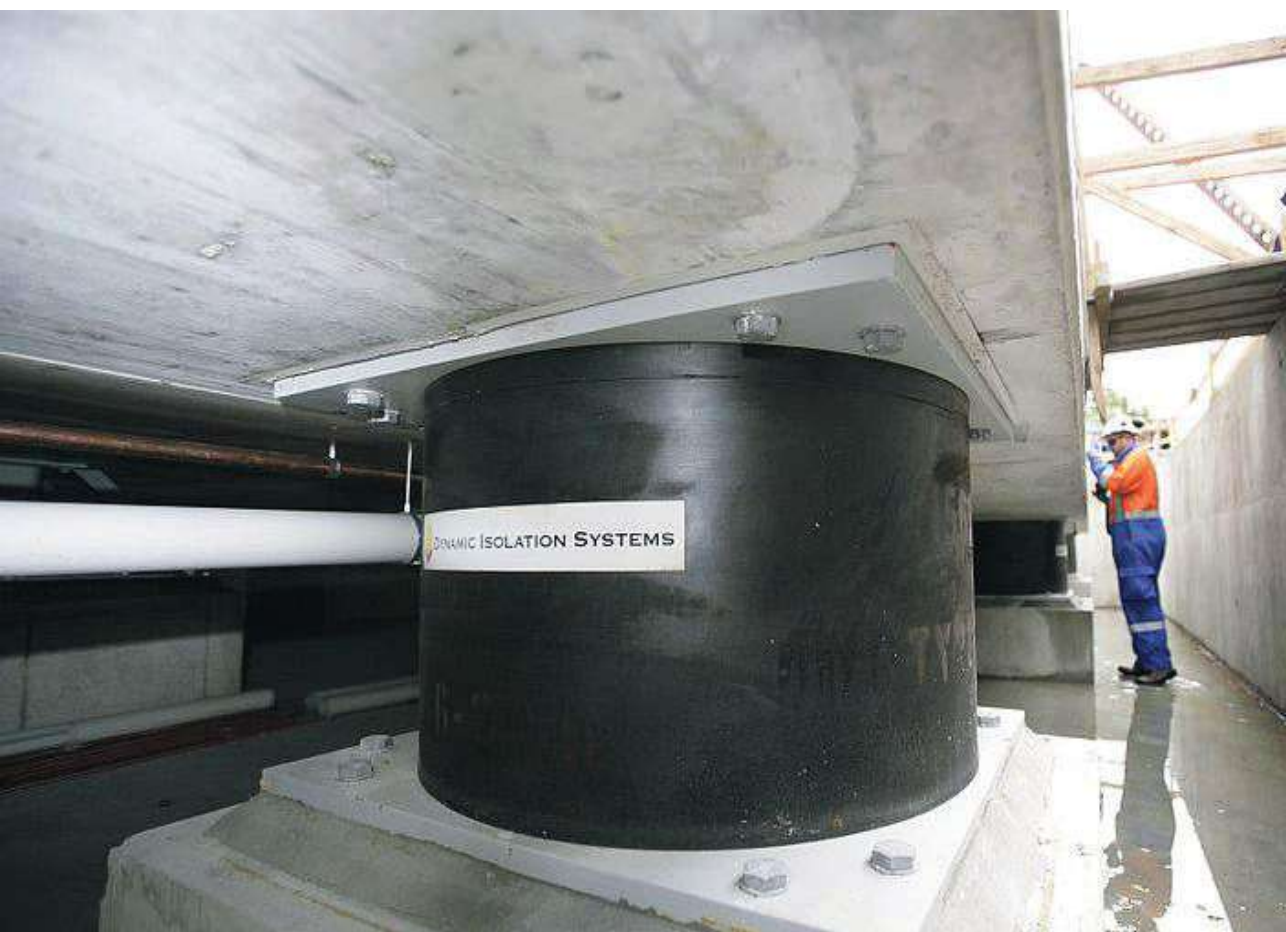
89 Isolatore sismico viscoso in neoprene.
