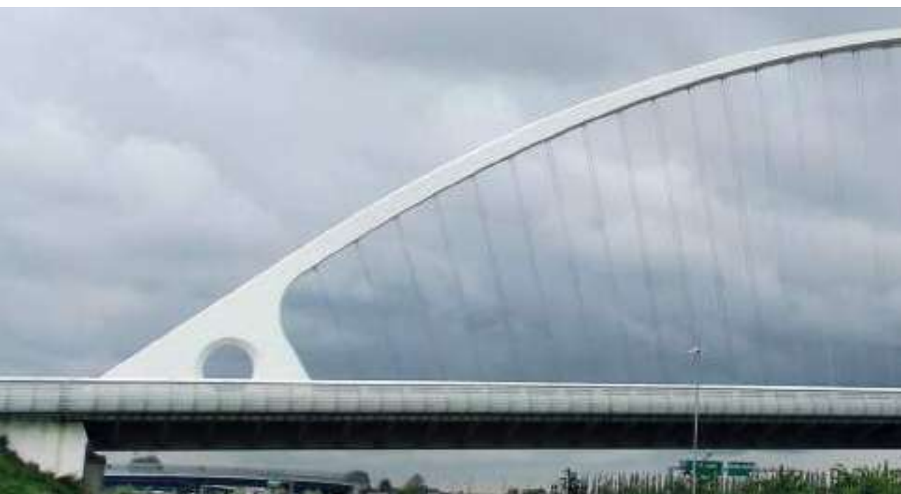
20 21 Santiago Calatrava, ponti sull'Autostrada A1, Reggio Emilia, 2007.
