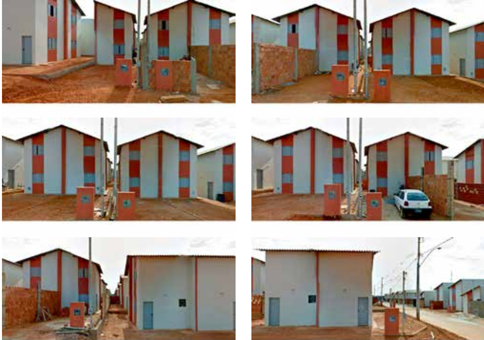
57. Sequenza lungo una strada di Vila DNOCS, durante la costruzione
