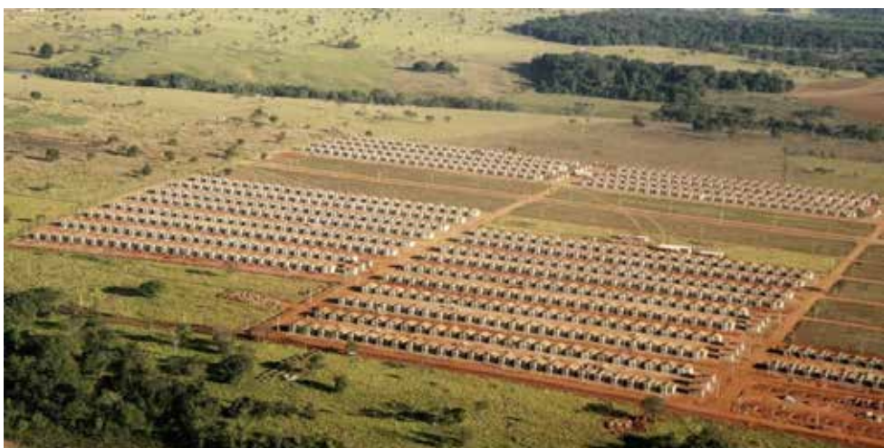
88. Un insediamento di social housing di Minha Casa Minha Vida intorno al 2005 [Fonte: Angéil M., Hehl R., a cura di (2013), Minha Casa, Nossa Cidade: Brazil's Social Housing Policy & The Failures of the Private-Public System]
