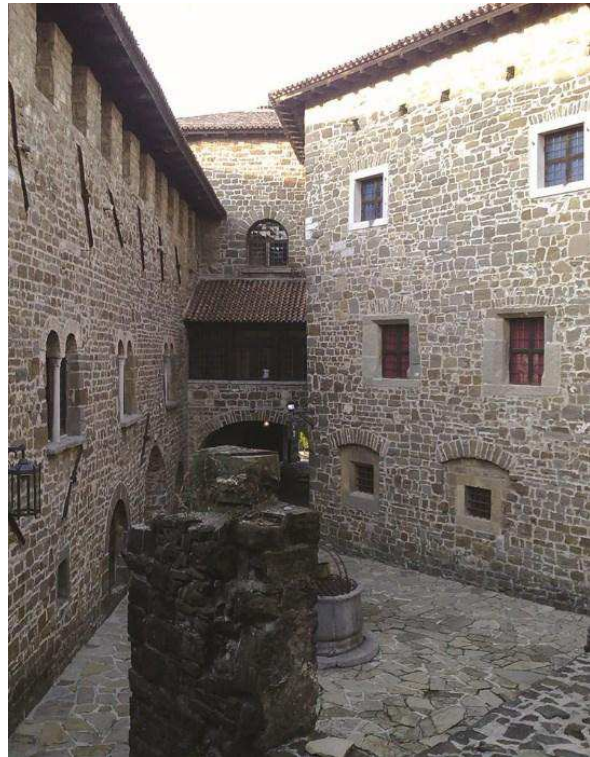
Fig. 3- La corte dei Lanzi nello stato attuale
