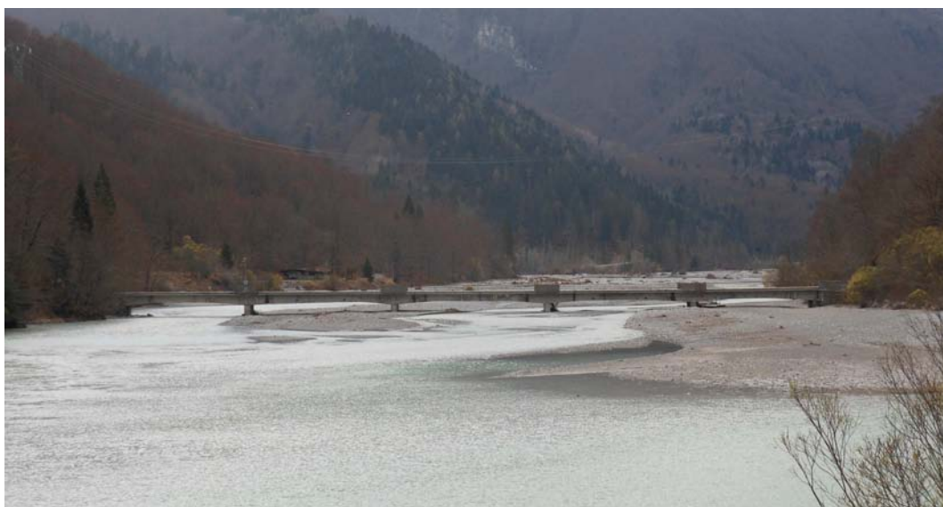
Fig. 9.5 Il ponte sulla SR552 visto da valle. L'impalcato è sorretto da 4 pile in alveo. Il corso principale del fiume si localizza sotto la campata di sinistra (SE). Si noti la differente luce verticale tra le 5 campate. Situazione ad inizio 2019.
