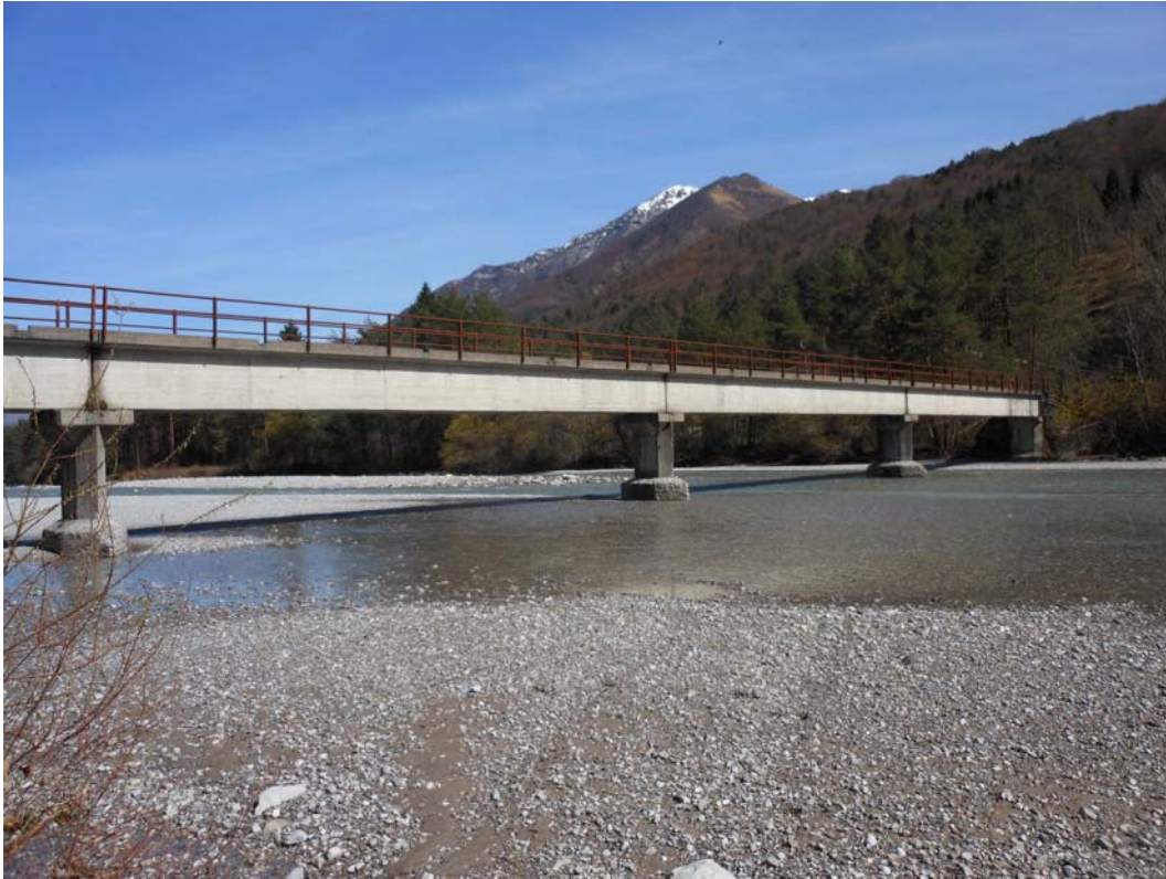
Fig. 9.9 Il ponte su viabilità secondaria in località Casolari Seletto, visto da monte. L'impalcato è sorretto da 3 pile in alveo con altezza utile di 3.6–3.7 m. Sulla sponda destra, poco più a valle del ponte, si trovano due edifici civili.
