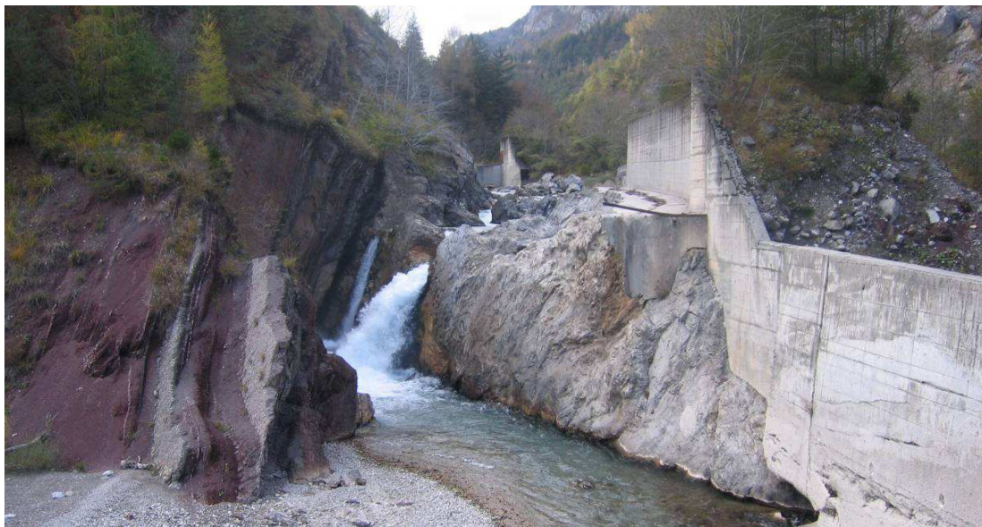
Fig. 9.3 Restringimento dell'alveo del F. Tagliamento in coincidenza del muro in calcestruzzo eretto a difesa della sponda sinistra (da relazione Puntel & Capellari Associati, 2015).
