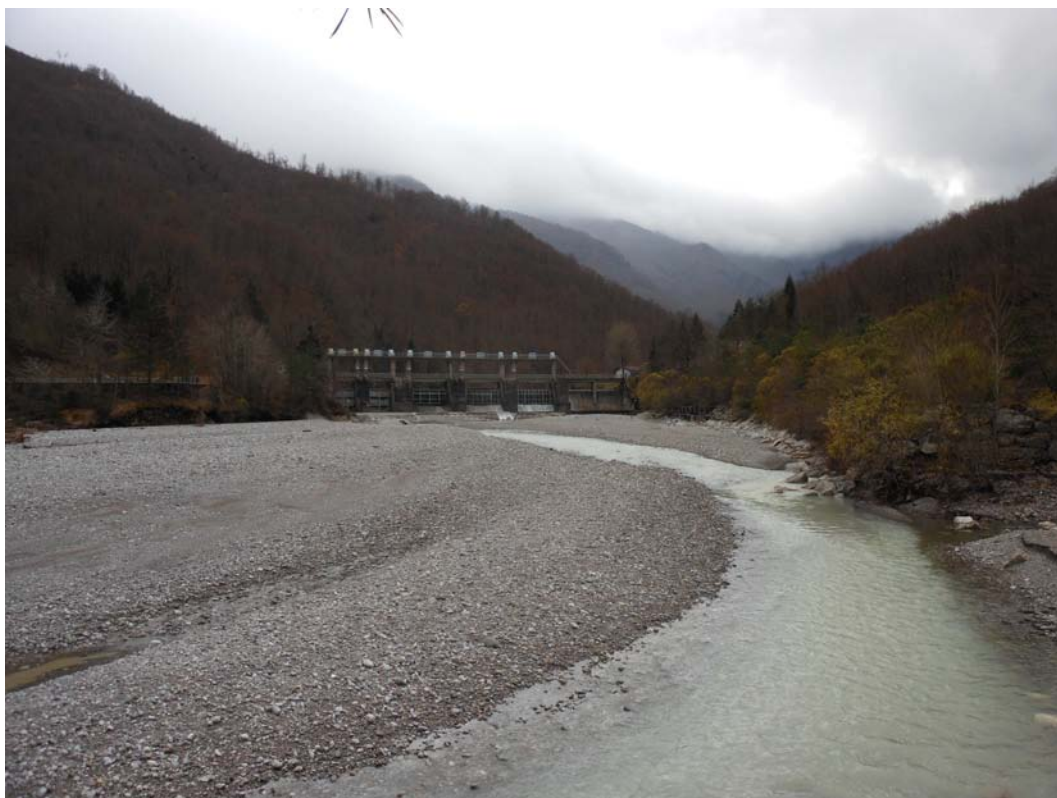
Fig. 9.6 Lo sbarramento di Caprizi visto da valle. Il corso principale del F. Tagliamento si trova all'estremità destra dell'alveo (a sinistra in foto, non visibile in quanto nascosto dalla barra ghiaiosa). In primo piano si nota un corso secondario del fiume rasente la difesa spondale in sinistra.
