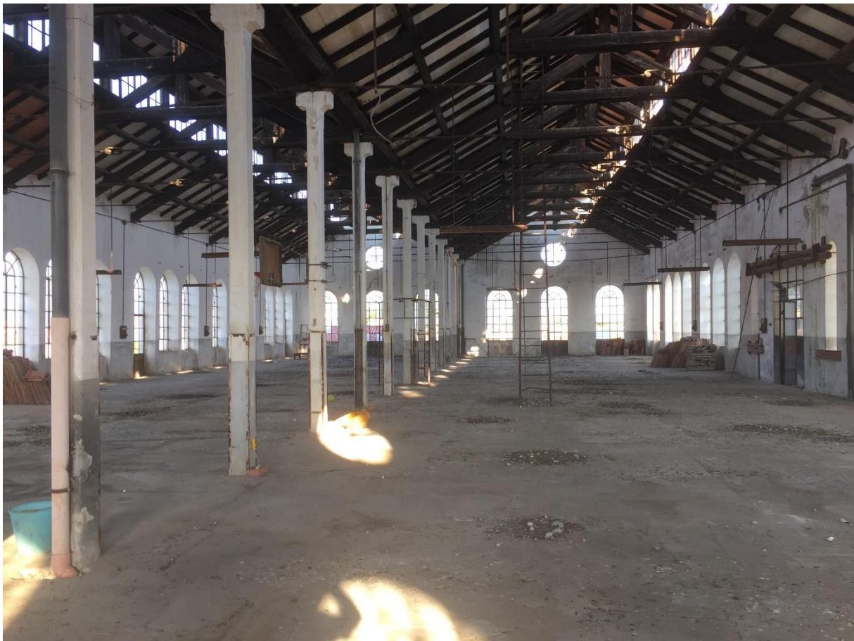
Figura 8. Imagen del interior de la antigua Hilandería en el centro de Carpaccio.
