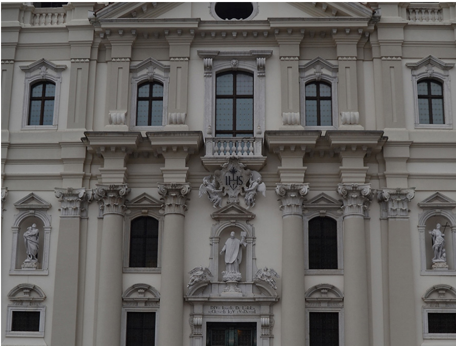
Fig. 168 - Tausch, Facciata, dettaglio della Chiesa di Sant' Ignazio a Gorizia. Mensole, archi spezzati e sculture, ordine composito gigante, Sant' Ignazio in posizione centrale.
