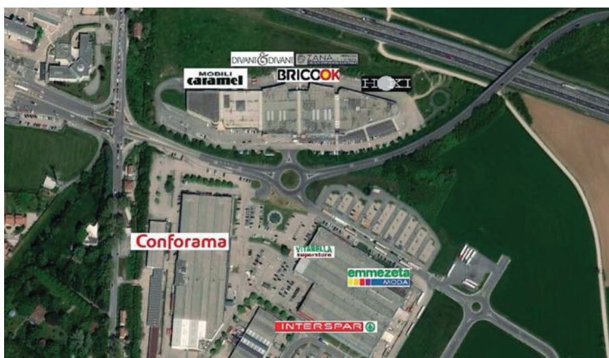
Fig. 8 - La veduta dall'alto di due complessi commerciali (il “Conforama – ex Emmezeta” e l’“Ex PRPC Merlana” sorti nel Comune di Bagnaria Arsa grazie alla presenza di grandi strutture specializzate singole
