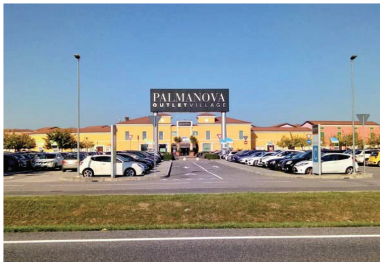
Fig. 10 - Il primo Factory Outlet Village realizzato nel nord-est dell'Italia
