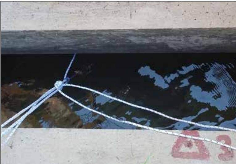
*Figura 57: Canale di convogliamento verso le sale pompe. L'acqua presente viene convogliata nei bacini di aspirazione (la sonda si trova a monte dei due bacini specifici) pertanto può finire indistintamente su entrambe le adduttrici. Il canale è interessato da un significativo flusso d'acqua che dipende dal funzionamento delle pompe di sollevamento. Al fine pratico, il punto è considerato come la sorgente della risorsa da sfruttare. Foto dell'autore.*
