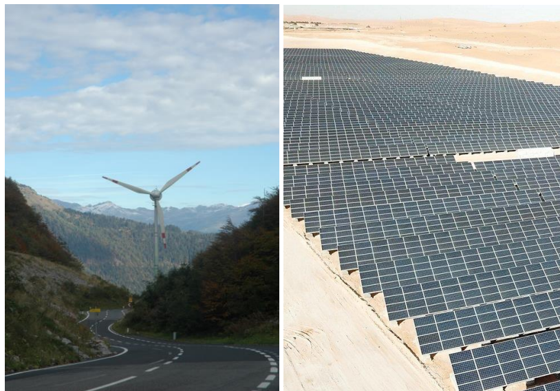
Figura 3. A sinistra: rotore eolico in Austria nei pressi del Passo di Monte Croce Carnico ( Plöckenpass ) (Foto: G. Battisti). A destra: Figura 4. Bir Rebaa North (Algeria): il progetto fotovoltaico dell'ENI (Fonte: < https://www.eni.com/it-IT/attivita/algeria-bir-rebaa-north.html >)
