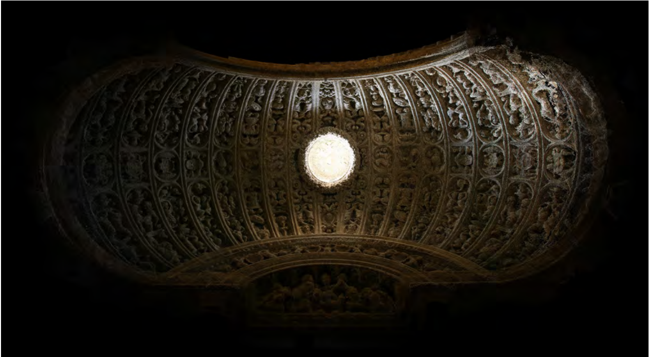
Fig. 1. Nuvola di punti della volta della Capilla de Junterón (elaborazione digitale A. Bortot).
