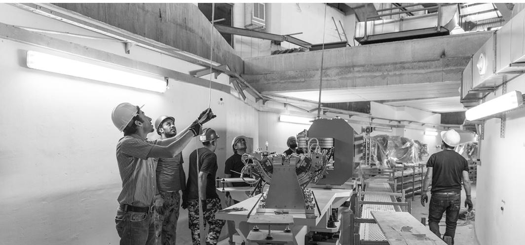
Fig. 4. I lavori di installazione di una sezione di camera da vuoto dell'anello di accumulazione di SESAME.
