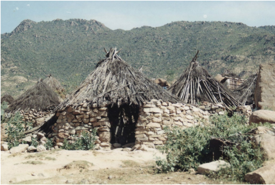
FIGURA 15 – Daasa/soqhlo a Laacaytan (fonte: foto Vergari 2000)
